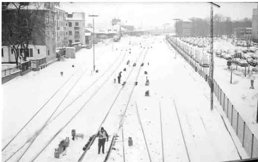
Inden vinteren var forbi, skulle der tændes sporskiftevarme og skiftes gasflasker mange gange. Her er personalet i gang på Aalborg Station. Sporskiftevarmen skulle tændes manuelt på stedet og gasflaskerne skulle jævnligt skiftes ud.
