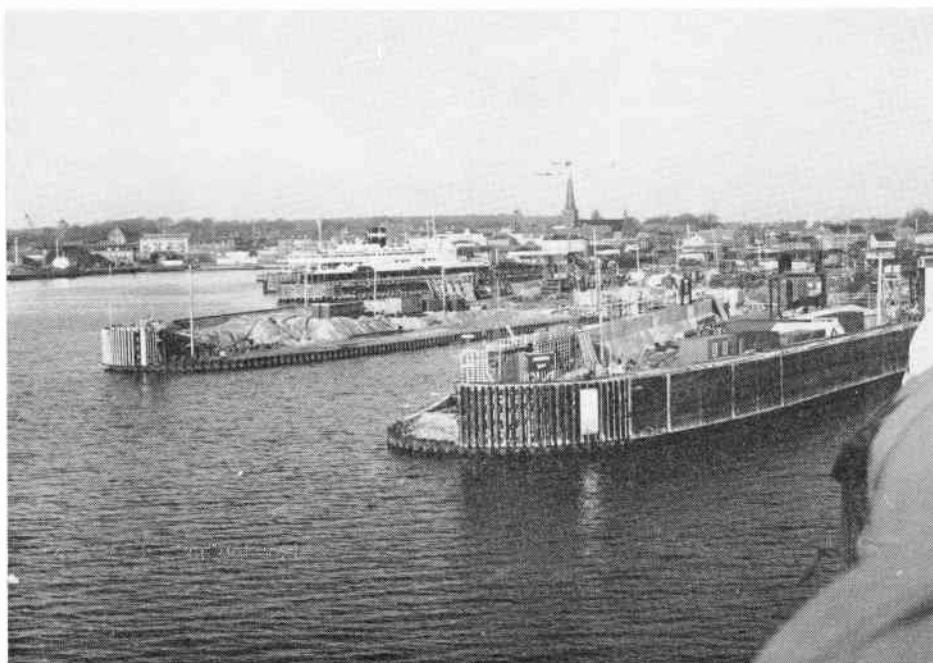
Det nye, brede leje 4 i Nyborg under bygning, 26. december 1979. Forhåbentlig vil de to Storebæltshavne Korsør og Nyborg snart blive udbygget med endnu et bredt leje i hver havn.
