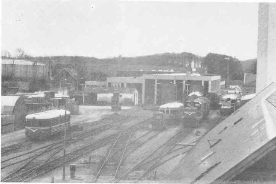
Det store remise- og værkstedskompleks under opførelse til HHJ i Odder, den 2. januar 1981. Foto: Ole Linaa Jørgensen.
