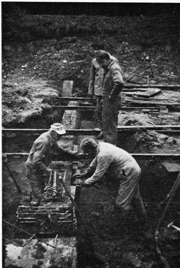
Jernkonstruktionen i endefundamentet inspiceres. Foto: Fl. H. Petersen.
