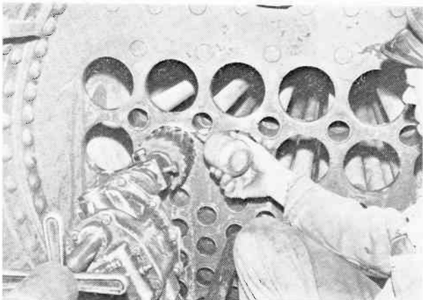
Hullerne til overhederrørene rives op, så de atter er runde. Foto: K. M. Jacobsen.
