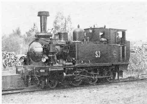
SJ 4041, tidligere ÖBj nr. 5, 1C-lokomotiv bygget hos Nydqvist & Holm i 1904, i Bergkvara, 1948. Foto: Birger Wilcke.
