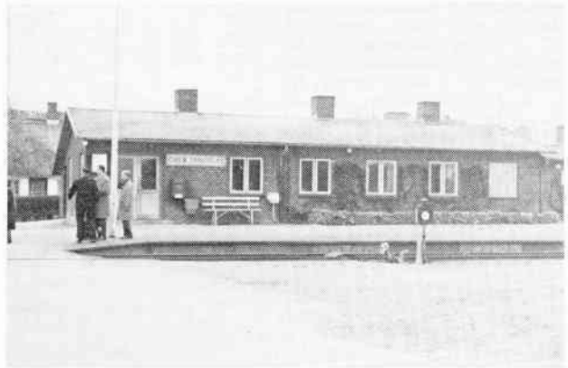
Over Tandslet station er et eksempel på en af de nye stationer, DSB lod opføre i forbindelse med systemskiftet. Billedet er optaget under en jernbaneudflugt den 13. maj 1962. Foto: James Steffensen
