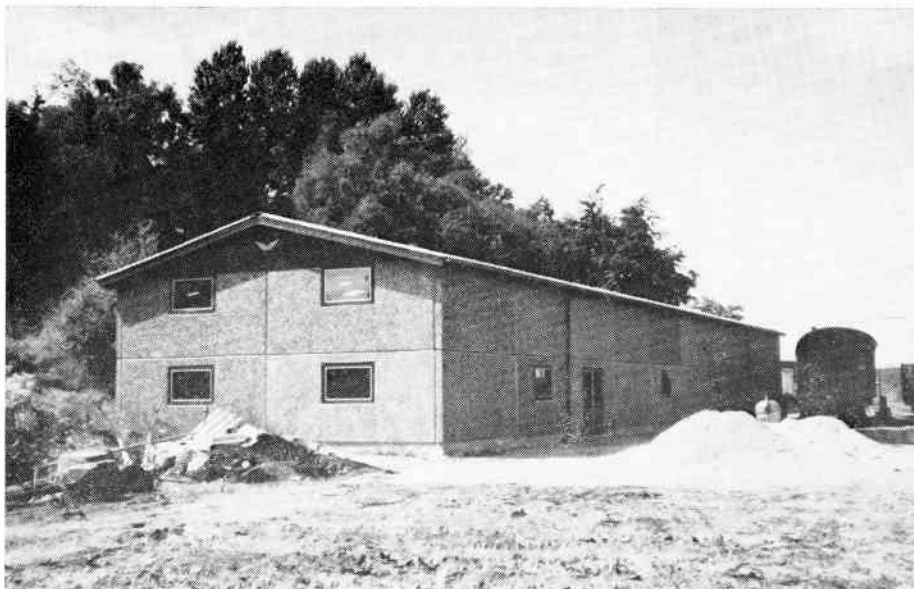
Det færdige byggeri set fra øst den 17. juli 1983. Vognen på billedet er CU 4249, der anvendes som værkstedsvogn.
