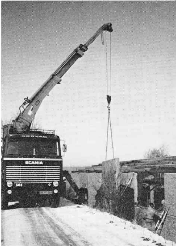
Remisebyggerne i Mariager anbringer endnu et vægelement med mobilkran den 30. december 1982, som var en solrig frostdag.
