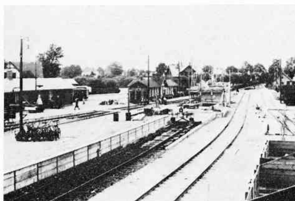
Ombygningsarbejderne på Vanløse station. Midt i billedet ses den nye, høje perron til de kommende S-tog. Bag sporstopperen er kommandoposten ved at tage form, og ved dens fod kan man se nedgangen til perrontunnelen som et sort hul. 1933. Foto: DSB Jernbanemuseum
