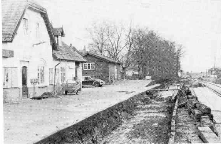
I forbindelse med sporombygningen på St. Merløse station blev det gamle spor 1 helt fjernet, 3. maj 1985. Foto: Ole-Chr. M. Plum
