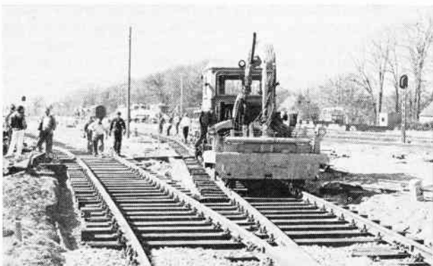
Baneafdelingen arbejder med ilægningen af den nye forbindelse mellem DSB og HTJ i Tølløse den 4. maj 1986. Foto: Ole-Chr. Munk Plum
