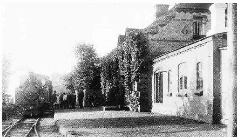
Stevning station, ca. 1914, med et af lokomotiverne fra 1913. Foto: Arkiv BW
