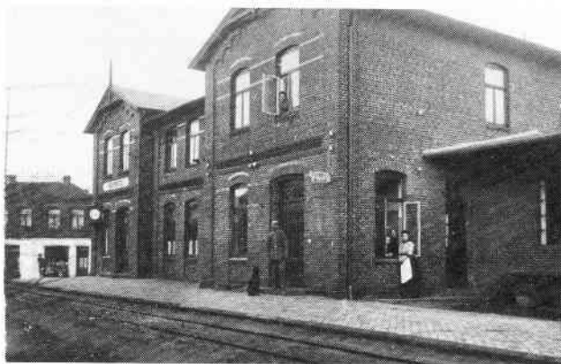
Nordborg station efter den anden ombygning, ca. 1915
