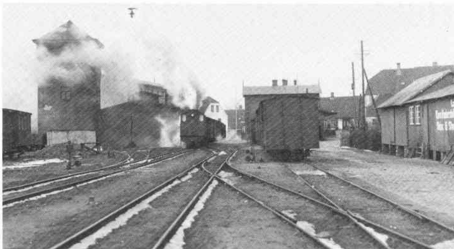
Nordborg station set fra syd, ca. 1924. I midten selve stationsbygningen og til venstre den to-sporede remise. Foto: Arkiv BW
