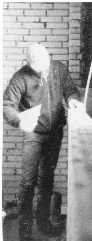
Selv om MHVJs folk selv kan klare mange entrepriser, er det af og til nødvendigt at få ekspertise udefra. For eksempel til opmuringen af de nye opholdslokaler. Mariager 1986. Foto: Anders Riis
