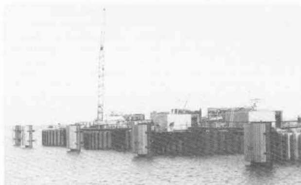
Det nye DanLink færgeleje er under hastig færdiggørelse. På billedet fra den 18. september 1986 anes de omtalte fire »trunter« (sænekekasser) Foto: Jan Forslund
