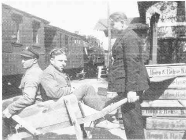
Ved togafgang i Skovby 1932. Til højre varehuset med vindfang, hvor der i den sidste tid var en slags ventesal.
