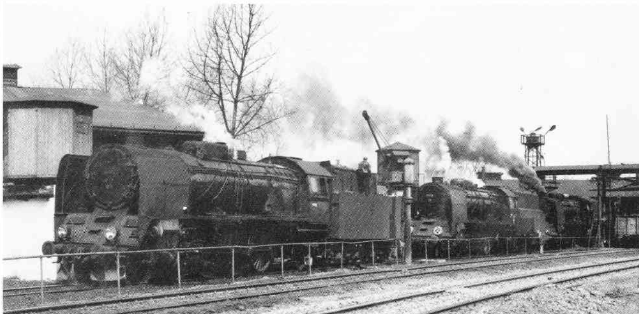
Tre Pt 47 maskiner varmer op før dagens træk. Klodzko den 18. april 1985.
