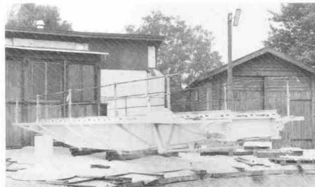
Drejeskiven i Nykøbing Sjælland under reparation inden ilægning. Foto den 23. august 1987: OCMP
