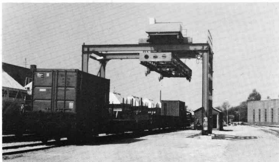
Lollandsbanens nye containerkran i Nakskov, med köftraktor M 8 foran containertoget. Til højre skimtes den nye store remise, som er dimensioneret til tre trevognslynetter - en imponerende bygning på en privatbane. Foto den 11. maj 1988: Jan Forslund
