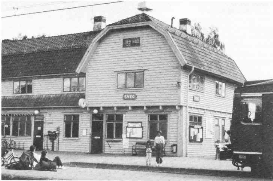
Sveg station, et trafikknudepunkt selvom det ikke passeres af ret mange tog dagligt. Ved kørsel med Inlandsbanan har man god tid til også at studere stationerne som bygningsværker, og Sveg er vel nok et ekstra studie værd. Foto den 14. juli 1986 af Knud Jensen
