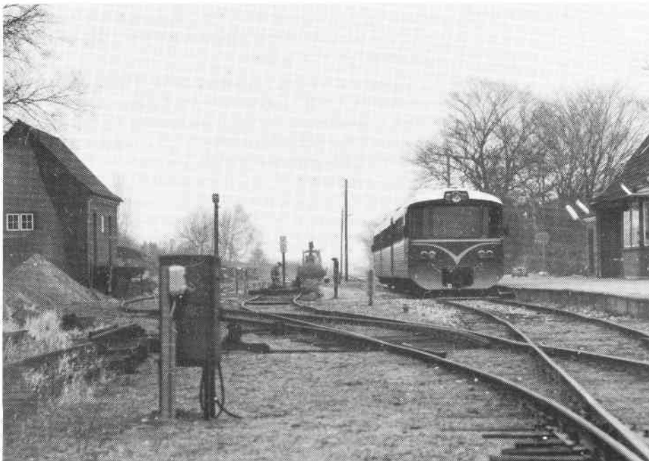
Spormoderniseringen i Tisvildeleje da den var ved at være tilendebragt. I baggrunden er trolig GDS 5 ved at fylde grusballast mellem de nylagte spor. Foto den 3. januar 1989 af Jan Forslund
