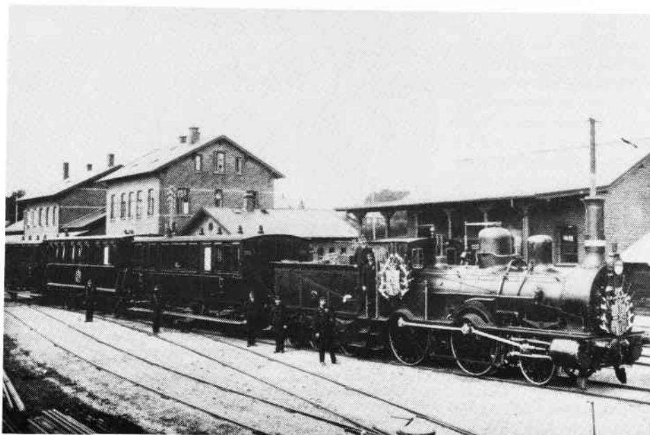
Kongetog (eller en del af et)? i Fredensborg - »hofstationen« - fotograferet 1891. Trækkraften er igen en F(s)-maskine. Gallaudsmykningen med rigsvåben og dannebrog skjuler driftsnummeret. Maskinen er dog formentlig en af de tre sidstbyggede - dem, som Sächsische Maschinenfabrik i Chemnitz havde leveret i 1888. Den treakslede tender tyder på det. Det samme gør dom og sandkasse; de er uden den for datidige Esslingenlokomotiver så typiske profilering. Den høje vogn med våbenskjold på siden er den treakslede kongelige salonvogn (S 1) fra 1871. Ikke bare det rullende materiel, men også personalet er strampudset, og medaljer luftes. Arkiv Jernbanemuseet
