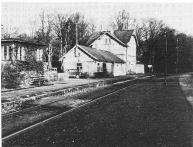
Skive Nord station. Længst til venstre signalhuset med centralapparatet. I dag er stedet uigenkendeligt. Arkiv: Skive st.
