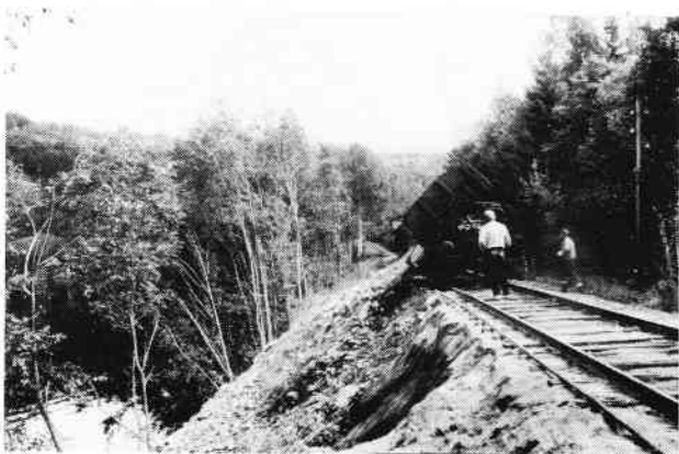
220 190 ved dæmningskredet i km 166,05 mellem Fossebrekke og Kjørre. Stenene styrter ned i hullet, mens baneformanden til højre ser til. 21. juli 1988.
